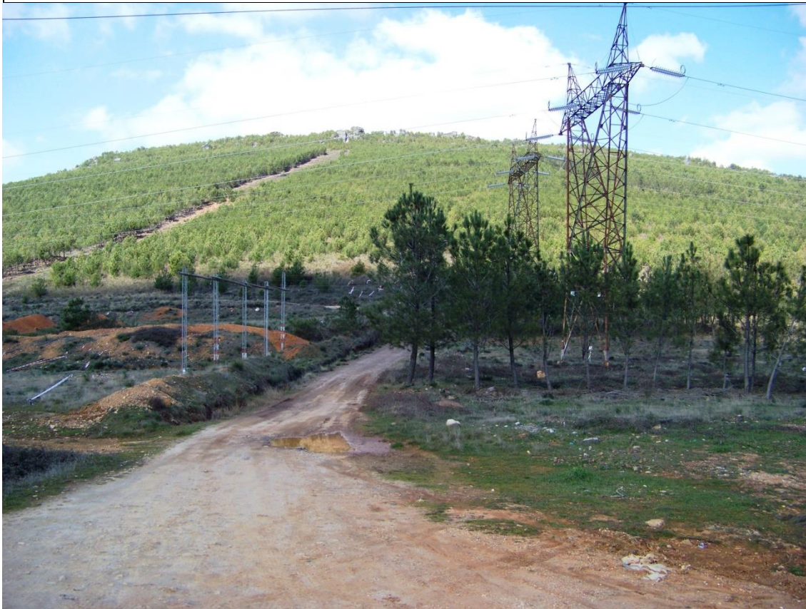
Figura 27 - Linhas de alta e muito alta tensão na base sul do cabeço da Mua
