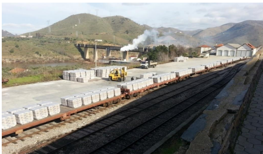
Figura 91 - Plataforma de mercadorias do cais ferroviário do Pocinho durante a descarga de paletes de cimento
