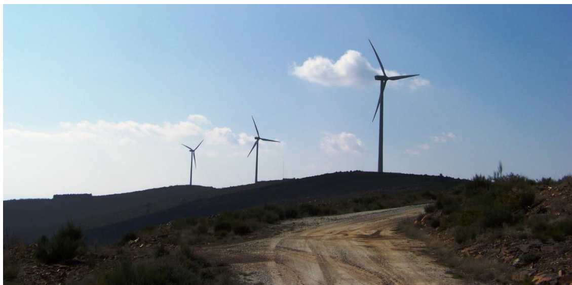
Figura 28 - Aerogeradores implantados em 2008 na crista mineralizada da Pedrada
